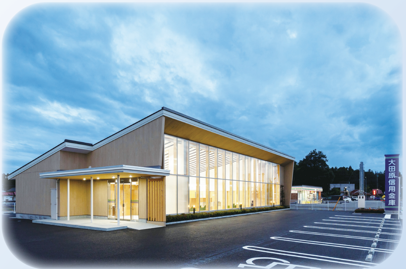
野崎支店（2022年11月7日 新築移転オープン）
